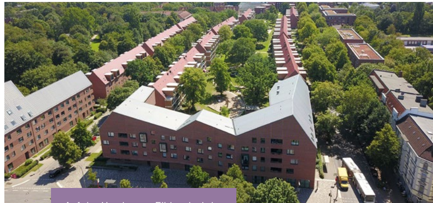
Auf der Hamburger Elbinsel wird das Weltquartier mit Fernwärme aus direkter Nachbarschaft versorgt.
